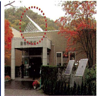
ソーラーパネルが設置された 「動物科学館」
