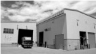
勇払リサイクルセンター（NEDO「北の大地エネルギーとの共存」より出典）
