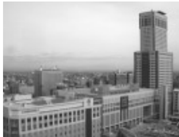
「札幌駅南口エネルギーセンター」があるJRタワー
