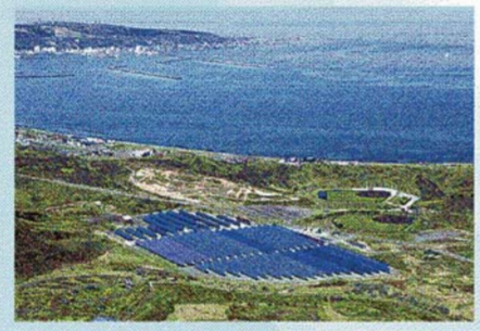
▲稚内メガソーラー発電所 (写真撮影:株式会社明電舎)
